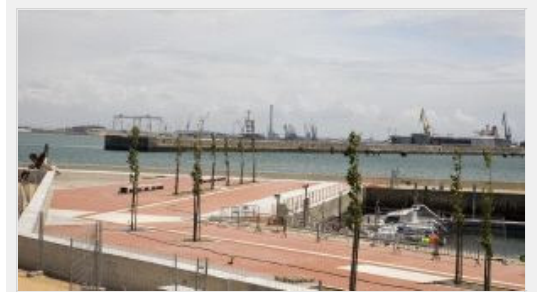
OBRAS. Al nuevo paseo arbolado le queda aproximadamente un mes para estar terminado. / MIGUEL GÓMEZ
